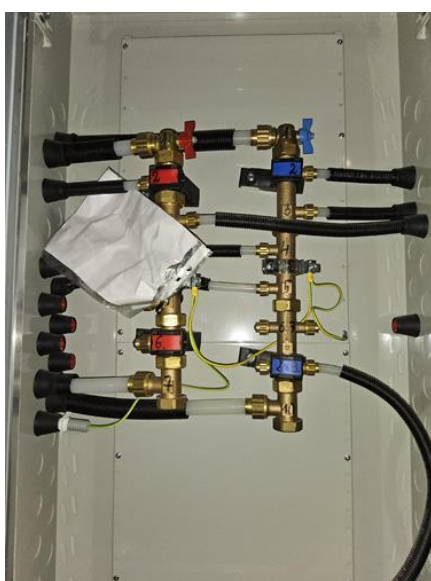
Tekniske anlegg, VVS anlegg (Sjekkpunkter utover det som er inkludert i andre rom) - [Samlestokk for rør-i-rør systemet]
