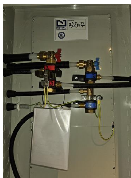
Tekniske anlegg, VVS anlegg (Sjekkpunkter utover det som er inkludert i andre rom) - [Fordeling, bad 4.etasje]
