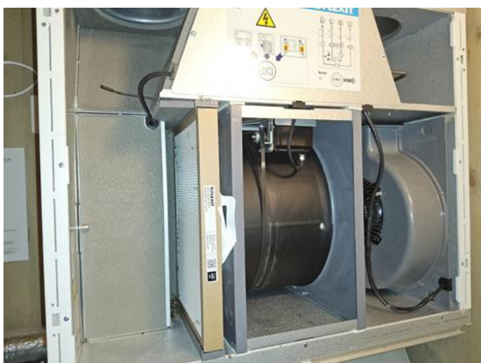
Tekniske anlegg, VVS anlegg (Sjekkpunkter utover det som er inkludert i andre rom) - [Ventilasjonsaggregat]
