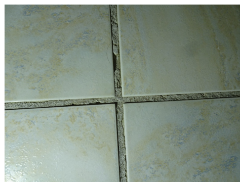
hardfuger (sementbaserte) har løsnet noe
