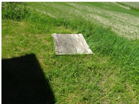
trelokk som ligger over septiktank
