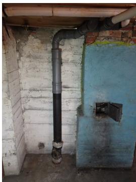
Nyere avløpsrør koblet inn på gammelt støpejernsrør
