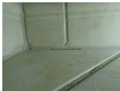
hardfuger (sementbaserte) har løsnet noe
