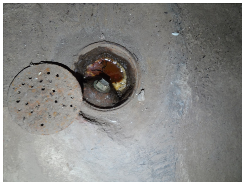
Gammelt sluk i den gamle kjelleren
