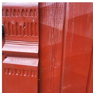
Ytterkledning (fasademateriale, vannbord, utvendig listverk, o.l.) - Eksempel på sprekker i kledning
