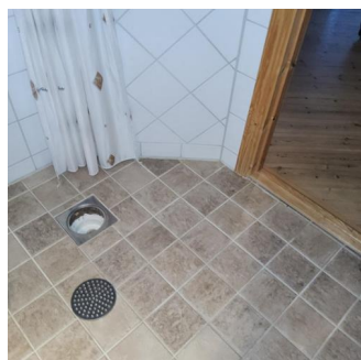
Fallforhold rundt sluk - Eksempel på kort avstand fra dusjsonen til dør
