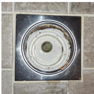
Avløp (inkl. sluk) - Sluk dusjsone
