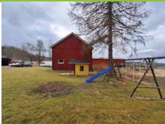
Østre side av fjøs med silobygg i bakgrunn
